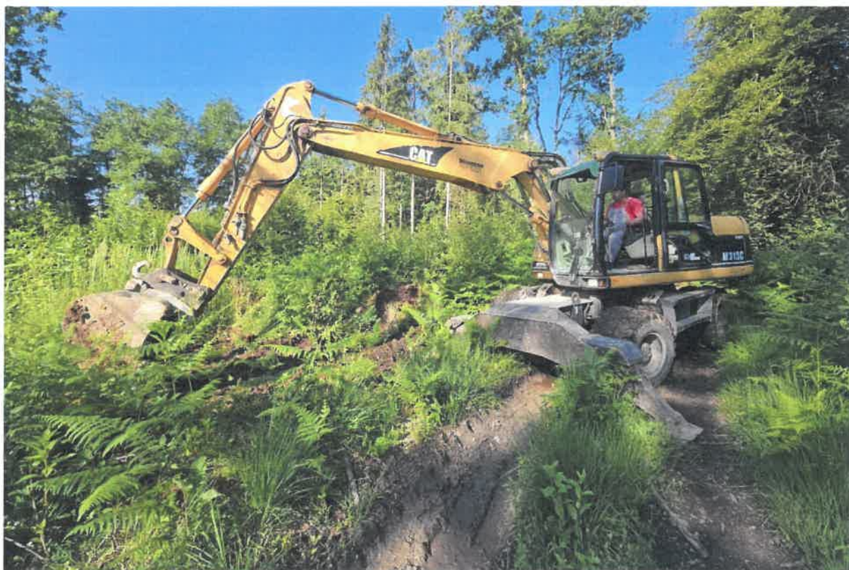
Slika 7: Fotografija izkopa sondažnega jaška S-2.
