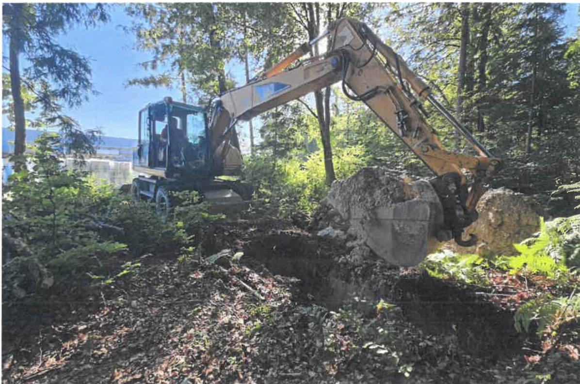
Slika 6: Fotografija izkopa sondažnega jaška S-1.
