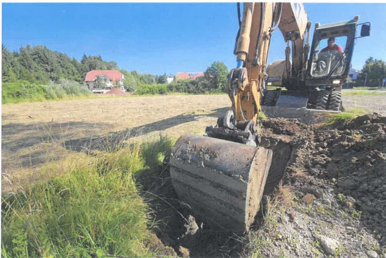
Slika 8: Fotografija izkopa sondažnega jaška S-3.
